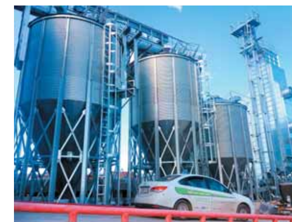
В 2019 году на территории знаменитого племзавода-колхоза имени 50-летия СССР был запущен сверхвысокопроизводительный промышленный поточный сушильный комплекс шведского производства Topput
